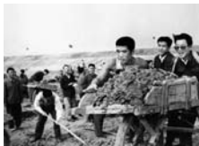
1982年10月11日，李瑞环（右一）参加京津工程渠开挖义务劳动。
